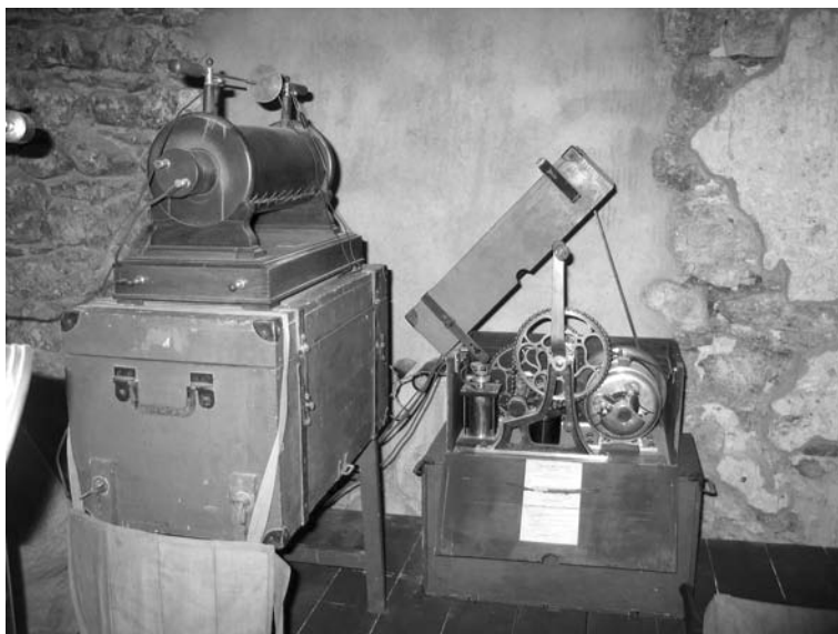
fig. n.2: Il gruppo generatore dell'alta tensione
